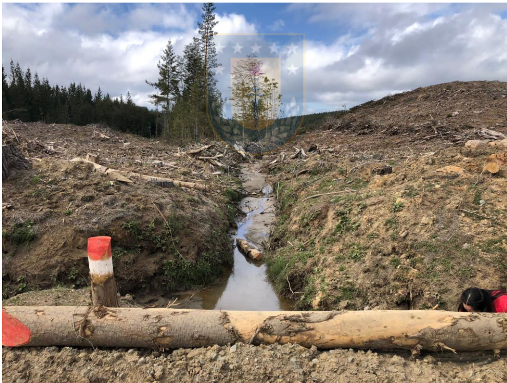
Figura N°17: Obra de alcantarilla y canal de escurrimiento originado por vertiente.
