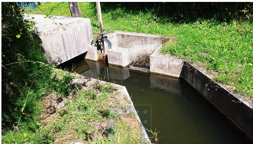
Figura N°34: Obras de captación de agua en estero San Ernesto.
