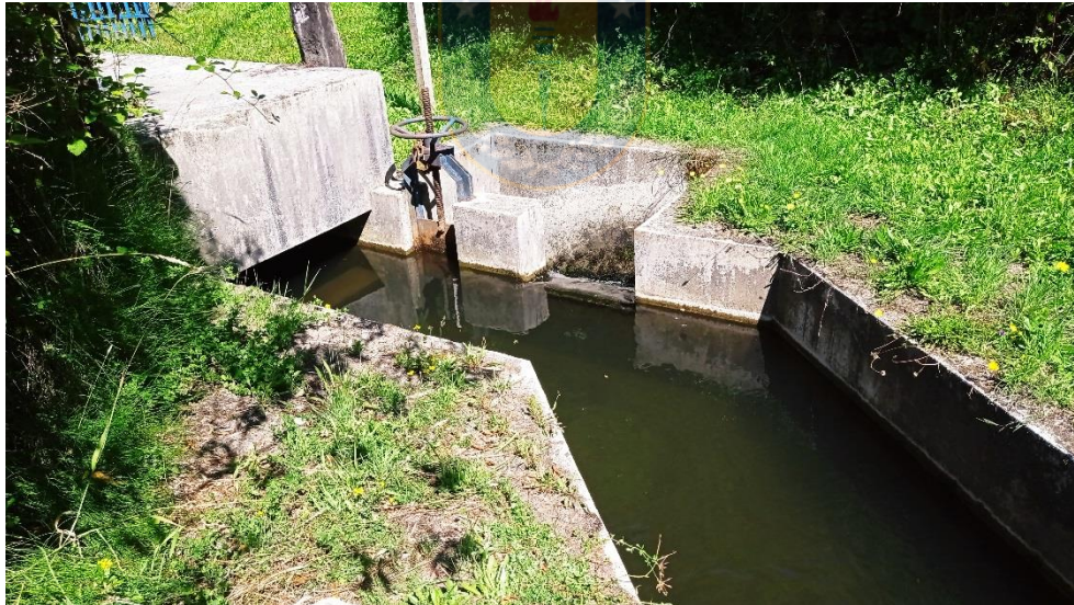
Figura N°8: Obras de captación de agua sobre el estero San Ernesto, APR Calebu-Elicura.
