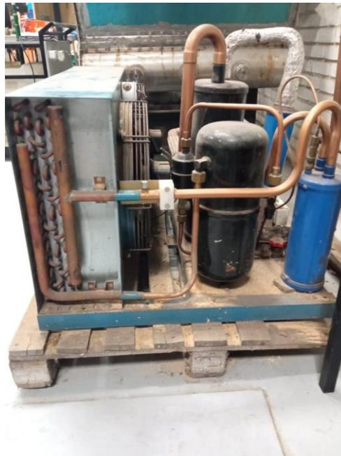
**Figura 10: Unidad condensadora**
