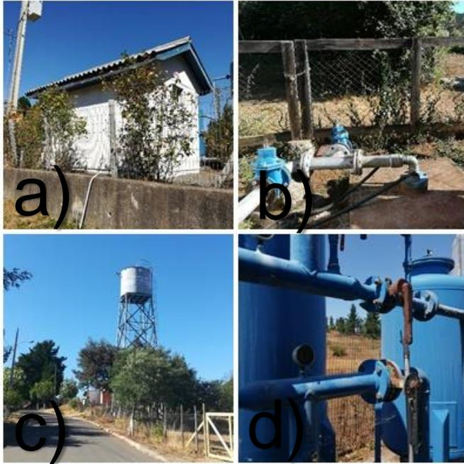
Figura 7.2: Sistema de agua potable de la localidad de Tomeco. a) Caseta de desinfección, b) Sistema de captación, c) Tanque de almacenamiento y d) Filtro en desuso.
