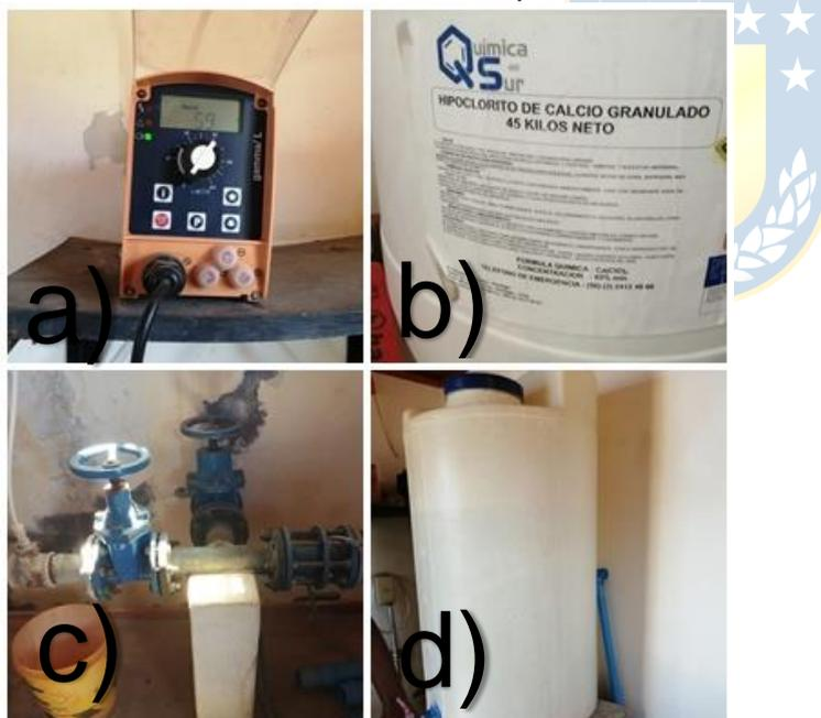
Figura 7.1: Interior de la caseta de desinfección de la APR de Tomeco. a) Bomba inyectora, b) Desinfectante, c) Tubos y d) Zona de mezcla para el desinfectante
