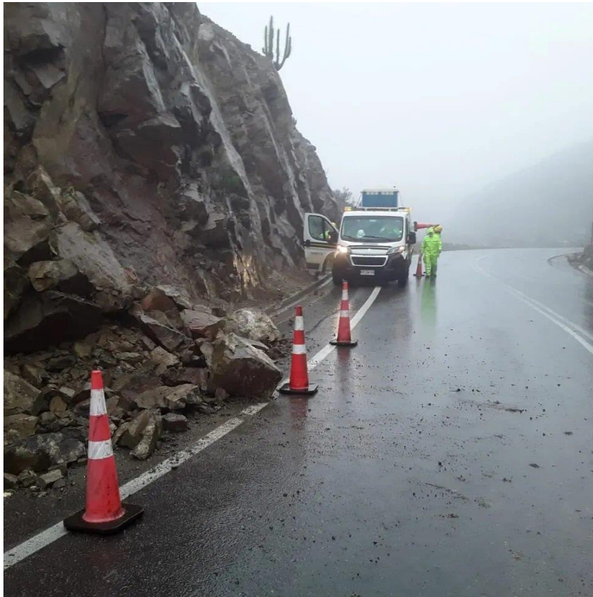
Figura 6.3 Ejemplo de colocación de elementos de canalización vertical. Situación requerida por la caída de rodados en la ruta D51 en la comuna de Andacollo, región de Coquimbo
