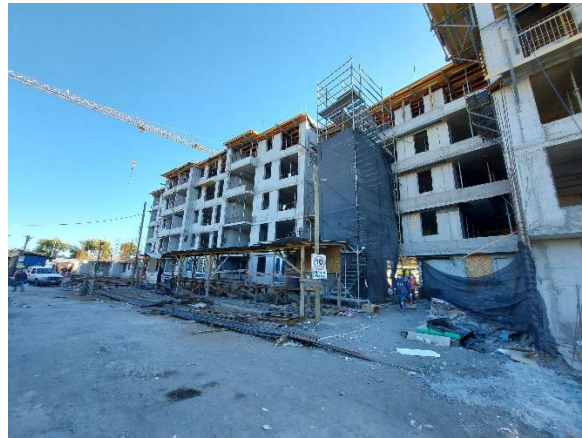
Figura 4.8. Obra gruesa de Torre Norte en proyecto Espacio Huertos.
