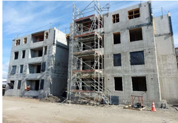
Figura 4.1. Obra gruesa de edificio N°2 en proyecto Condominio Esperanza.
