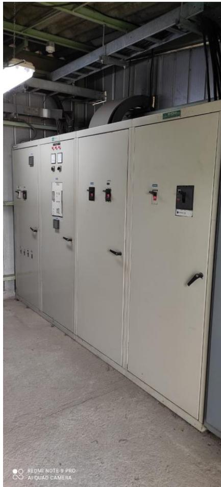
*Figura B.3 Tablero subestación 1250 kVA Empalme Rol 2.*
