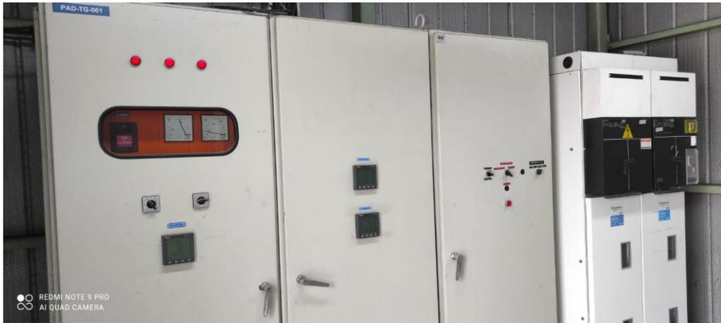
*Figura B.6 Tablero subestación 500 kVA Empalme Rol 2.*
