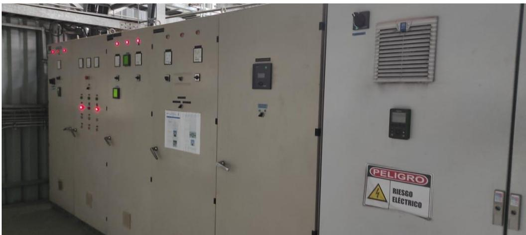
*Figura B.1 Tablero subestación 1000 kVA Empalme Rol 1.*
