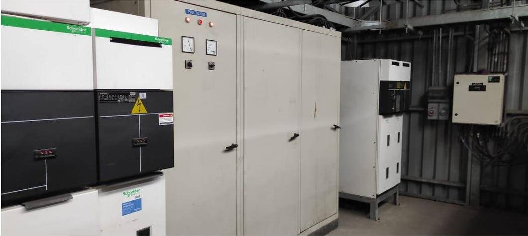
*Figura B.2 Tablero subestación 750 kVA Empalme Rol 1.*
