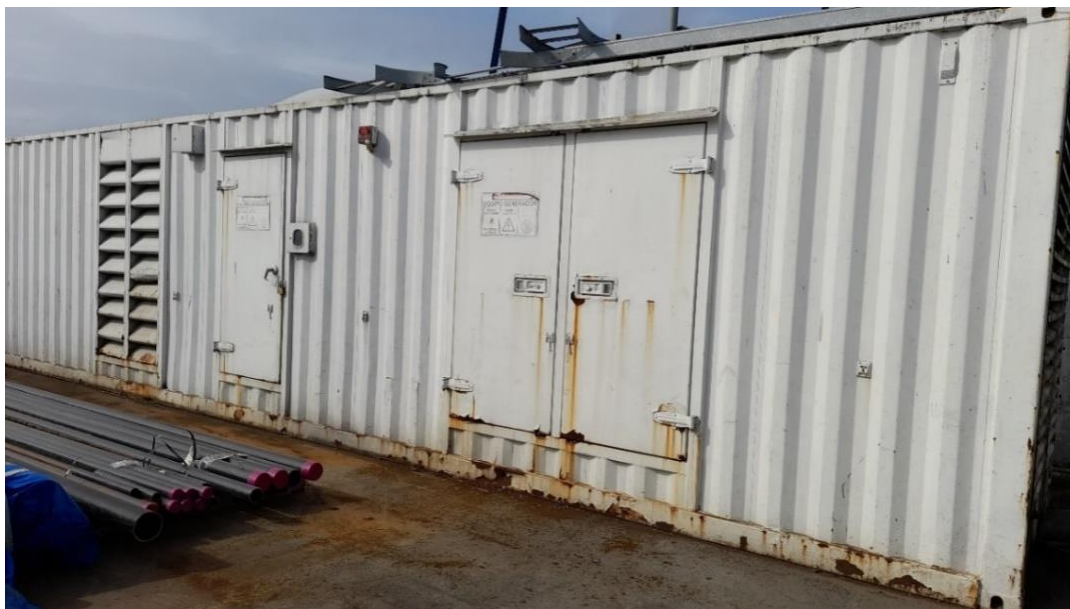
Figura 5.3.4: Generador diésel de 1MVA.
