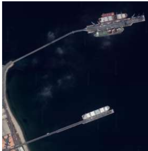
Figura 1.6: Imagen satelital de DP World Lirquén, de arriba hacia abajo muelle N° 2 y muelle N° 1.
