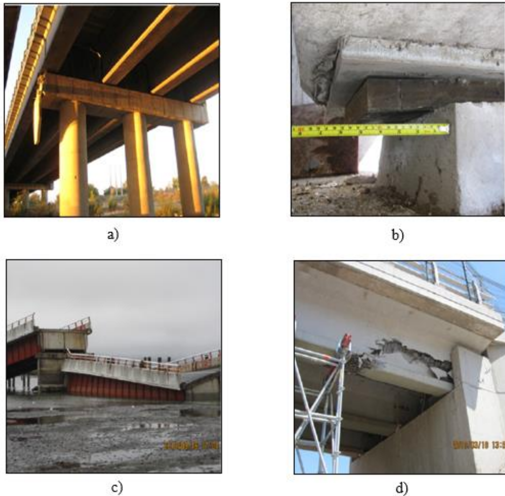
Figura 2.3. Principales daños de los puentes Chilenos durante el terremoto del Maule de 2010: a) Desplazamiento y rotación de la superestructura, b) corrimiento de apoyos elastoméricos, c) Colapso de la superestructura, d) Agrietamiento de vigas principales (Wilches et al., 2021).
