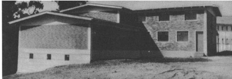
Figura 2.4 Edificio DIDECO, fotografía del año 1949 (Galleguillos, 1952).
