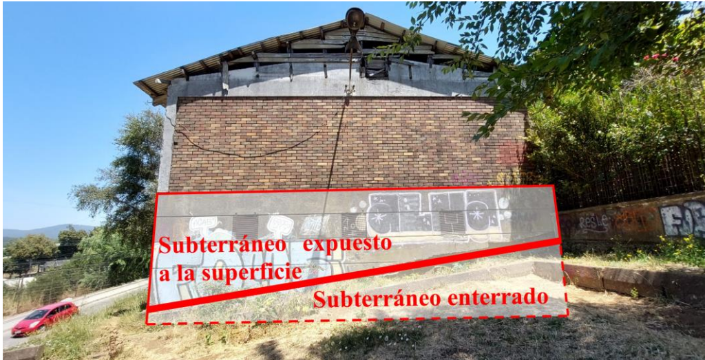
Figura A.4.3.4. 1 Exterior DIDECO, fachada noreste. Subterráneo enterrado versus expuesto.
