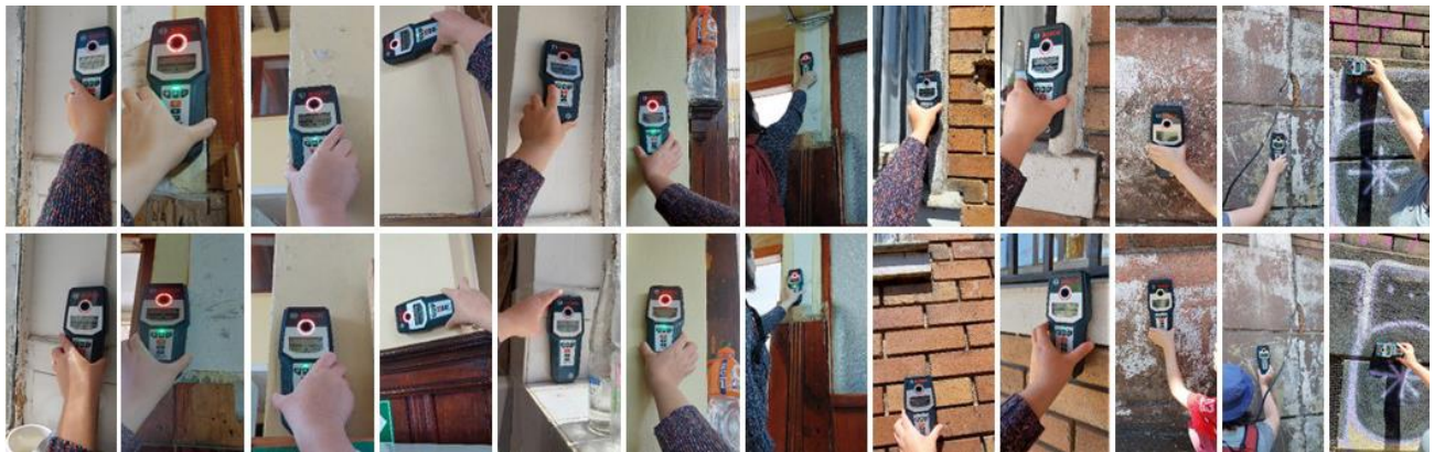
Figura 2.8 Revisión de estructura con detector de materiales, búsqueda de acero de refuerzo.
