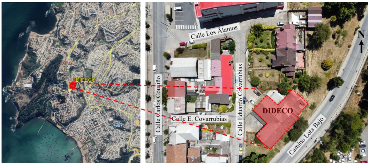
Figura 2.3 Ubicación Edificio DIDECO (1949) en la ciudad de Lota.
