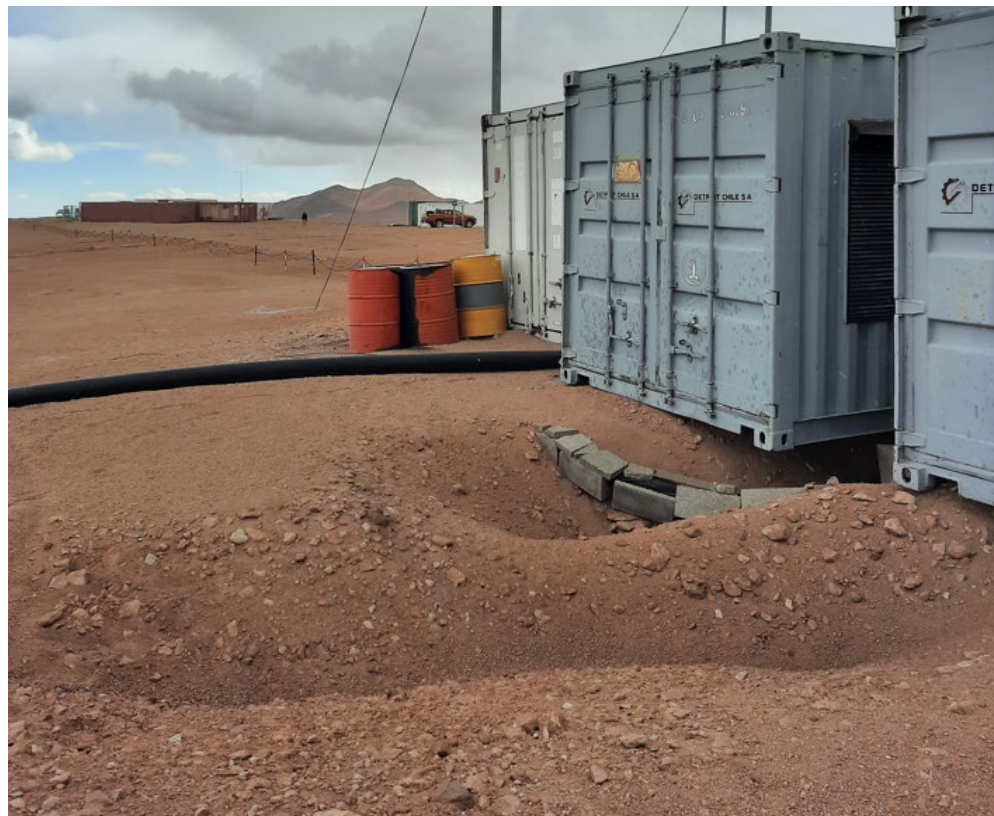
Figura A.2.1.6 Socavón en terreno con toba volcánica, guijarros sueltos y arena
