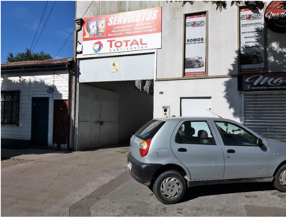
Figura 75. Frontis de taller automotriz tipo Serviteca. Fuente: Propia
