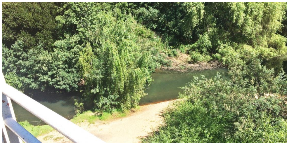
Figura 8. Registro fotográfico en Puente N°4, obtenida 12-12-18.
