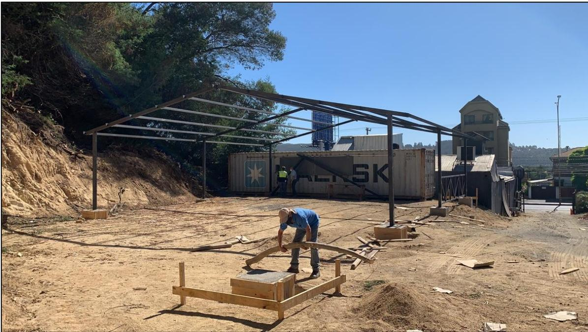
**Figura 6-4. Instalación de estructura para terraza.**
