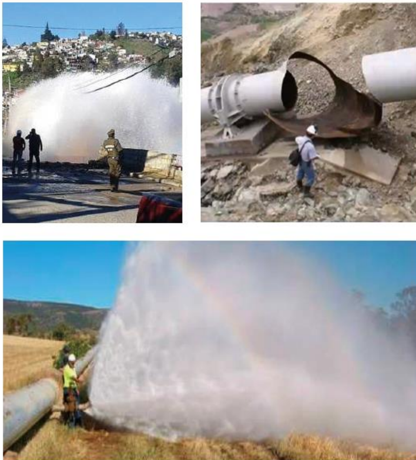
Figura 2.3: Colapso de cañerías por sobrepresión. Fuente: [23]
