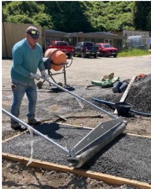
Figura 3.7 Construcción pavimento permeable: (a) Trazado del perímetro; (b) Excavación; (c) Colocación base granular; (d) Moldaje y humedecimiento del suelo; (e) Compactación con rodillo
