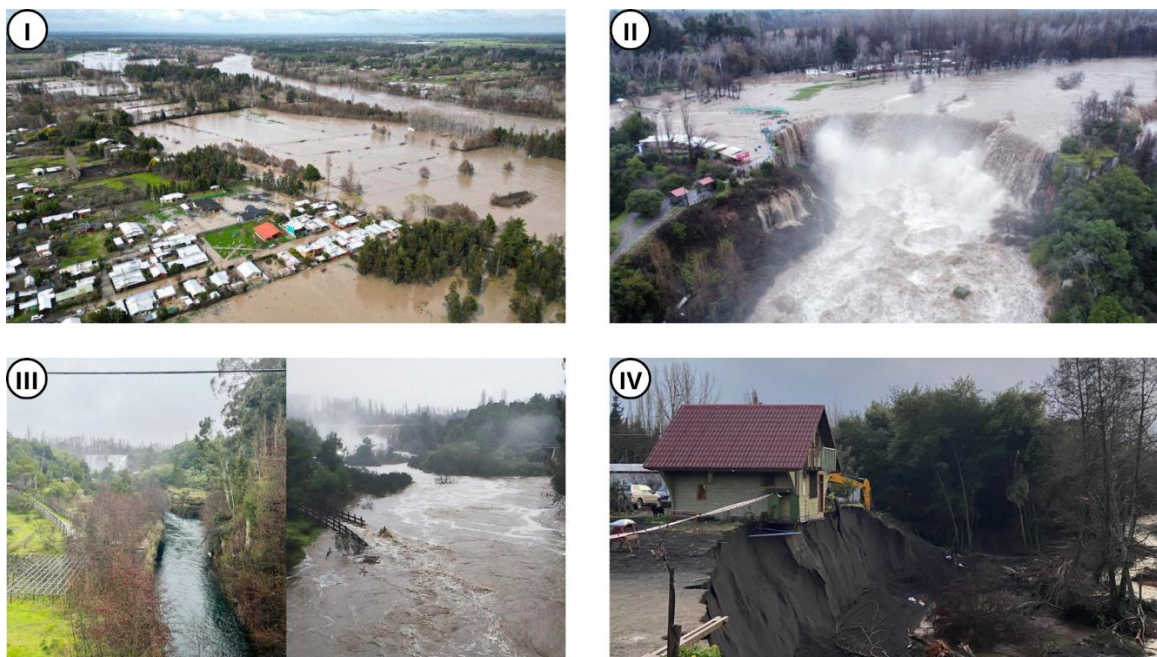
Fig. 5. 1: Mapa del sector Saltos del Laja, zona media del área de estudio, con marcadores I, II, III, IV que indican ubicación respectiva de las imágenes del sistema frontal del año 2023, mostradas en la parte inferior. I: sector Chillancito, inundado por desborde del río Laja. Extraído de: latribuna.cl. II: Saltos del Laja, con zona de locales y camping inundados. Extraído de: soychile.cl. III: antes y durante el temporal en el sector Saltos del Laja con los saltos de fondo. Extraído de: meganoticias.cl. IV: sector La Aguada, casa al borde de caer por socavamiento generado por el Estero Batuco. Extraído de: sabes.cl.
