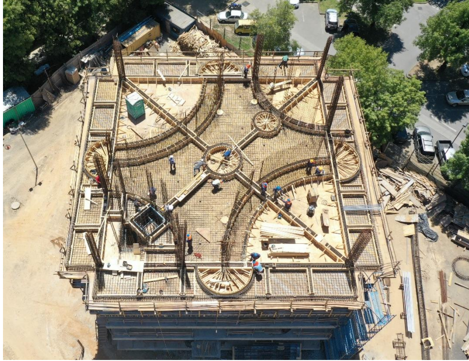
Figura 3.1 Imagen del proceso constructivo losa nivel 5
