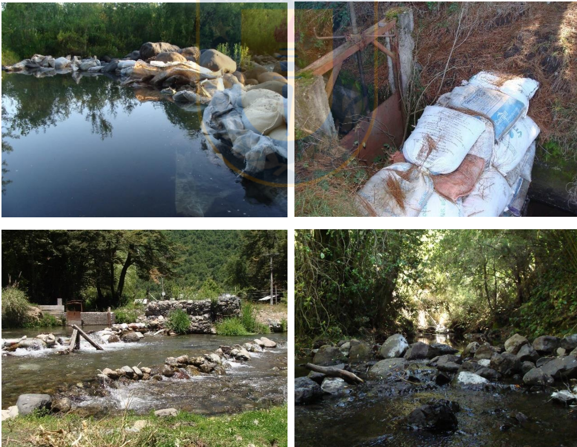
Figura 3. Métodos utilizados para la derivación del caudal en ríos de bajo orden.
