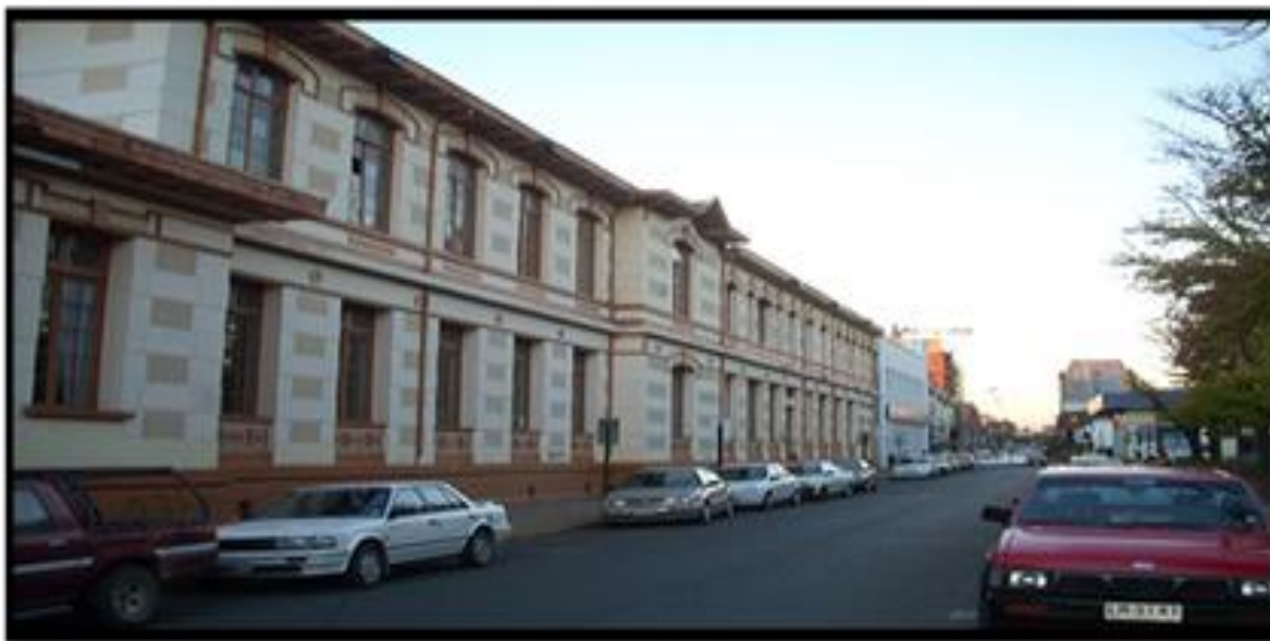
Liceo Ex internado de Hombres Ubicación: Lautaro 445/463 Fecha de construcción: 1905/1912 Extraído de: https://www.flickr.com/photos/95923824@N08/ Fecha de extracción: 28-12-2016
