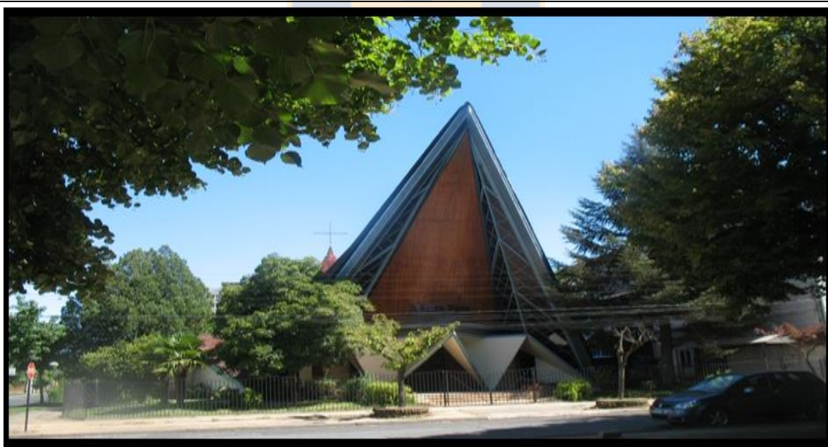
Capilla Liceo Alemán Ubicación: Patricio Lynch esquina O'Higgins Fecha de construcción: 1963 Extraído de: http://mapio.net/pic/p-18113329/ Fecha extracción: 28-12-2016
