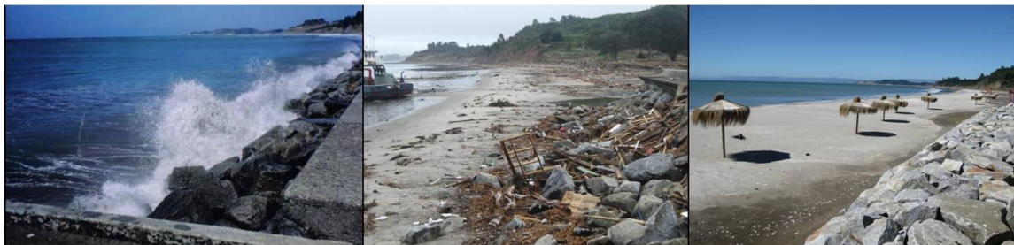
Figura 7. Llico (37,19°S/73,56°W). Izquierda 2007, centro 17-3-2010, derecha: 6-5-2011. Antes del terremoto la subsidencia cosísmica obliga la construcción de un enrocado, luego del terremoto el alzamiento cosísmico de 2 m provoca un retroceso del litoral y el tsunami genera muchos escombros (centro) y posteriormente las marejadas de 2010 depositan un gran volumen de arenas formando una extensa playa. Fuente: izquierda, Panoramio, restantes, propias.
