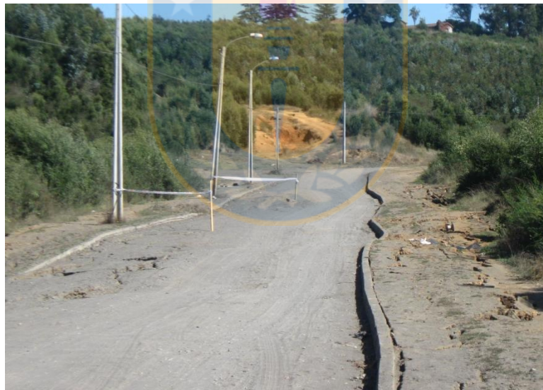
Figura 15. Ondulación del terreno debido a las ondas Love en el Puente Maule de la ciudad de Coronel (37°S). Fuente: propia.
