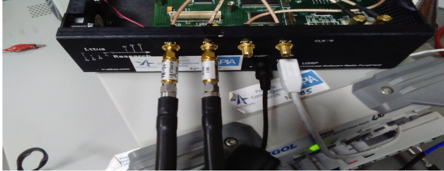
Figura 4.19: Atenuación entrada USRP. Fuente:Elaboración propia.
