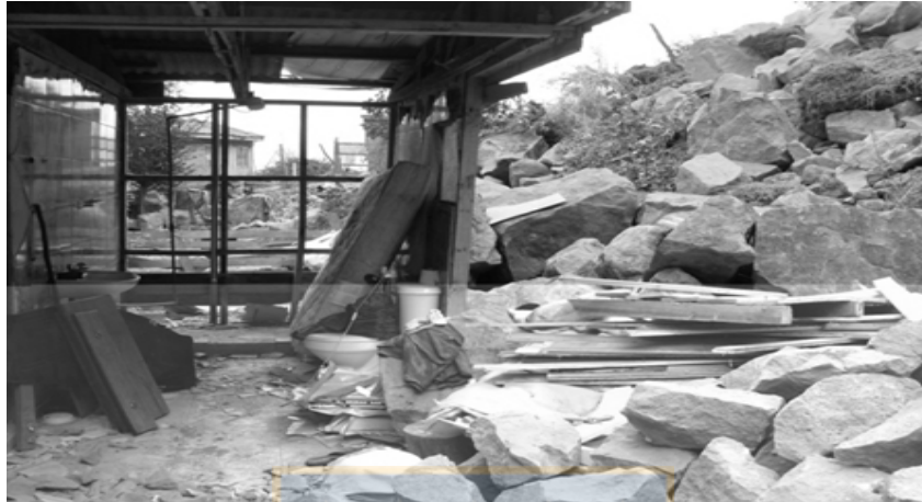
Figura 1.1 Caída de rocas ocasionado por el terremoto del Maule de 2010 en caleta Los Bagres (36.615009°S, 72.960889°W). Fuente: Mardones et al. , 2012.
