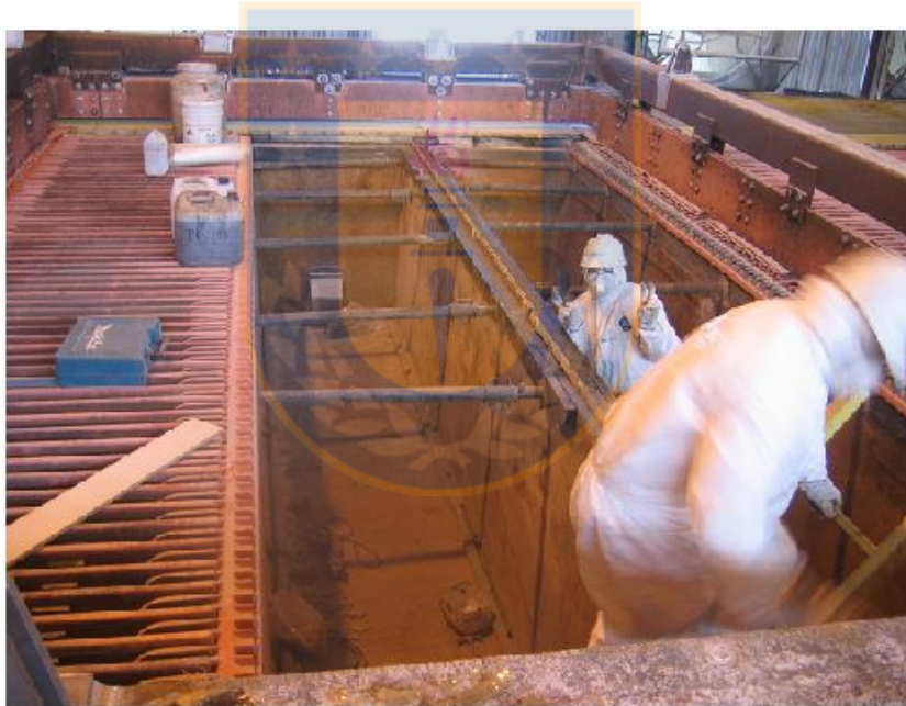
Figura 4.8 Instalación de Marco Cortocircuitador. Fuente: Elaboración propia.
