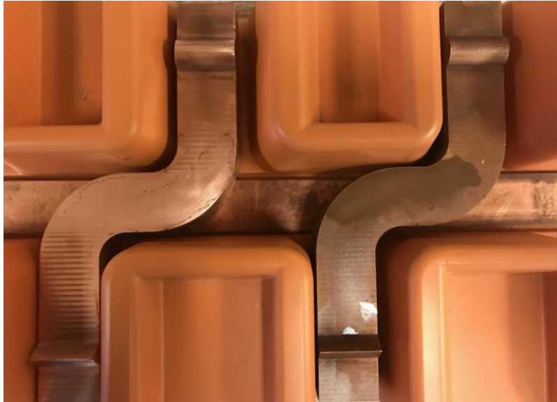
Figura 4.12 Barra equipotencial con conectores reemplazables propuesta. Fuente: Elaboración propia.
