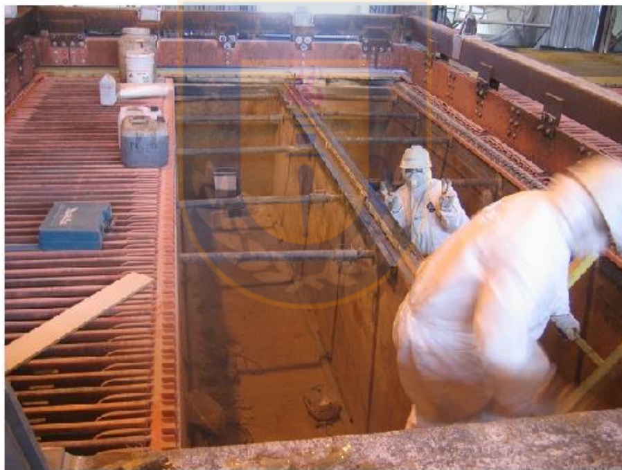
Figura 2.6 Celda de electro-obtención en proceso de reparación. Fuente: Elaboración propia.
