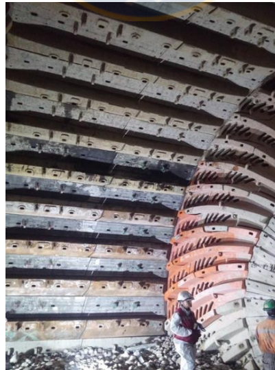
Figura A.3 Vista interna de molino SAG durante inspección del nivel de llenado (Fuente: CODELCO).
