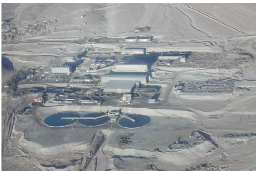
Figura 2. Planta Concentradora División Salvador, vista aérea.
