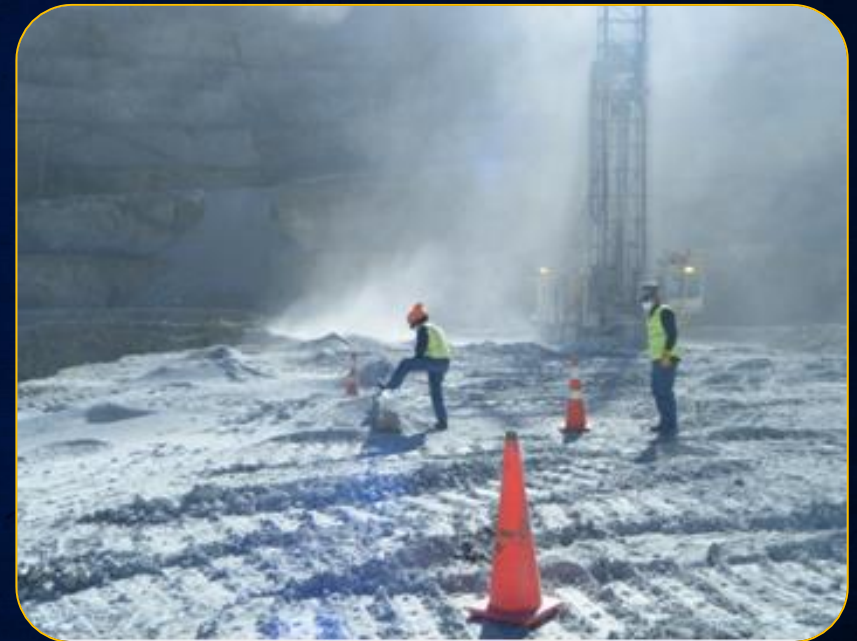
Figura 8. Muestreo de pozos de tronadura en mallas de perforación (Fuente: Elaboración Propia).
