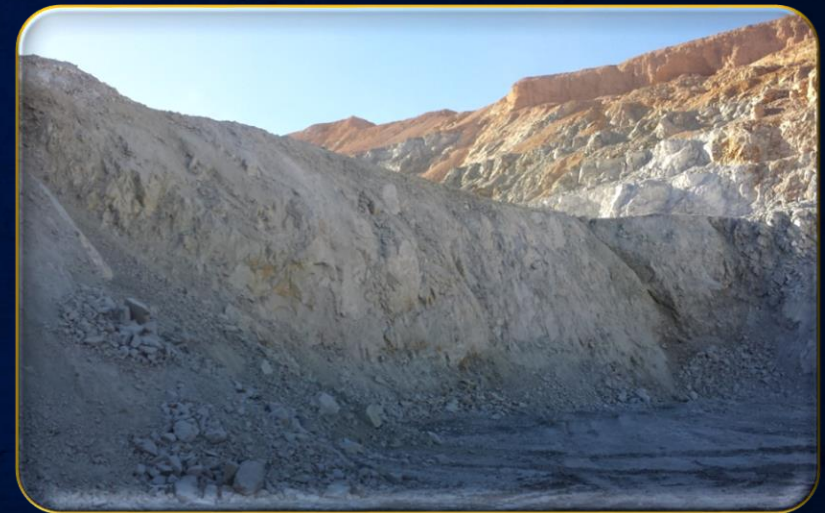
Figura 15. Calidad del macizo rocoso en una frente de extracción (Fuente: Elaboración Propia).
