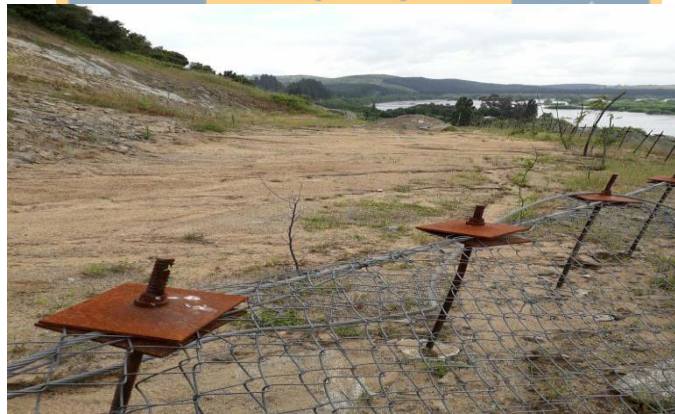
Figura 18: Puntos de Monitoreo del talud, tercera terraza
