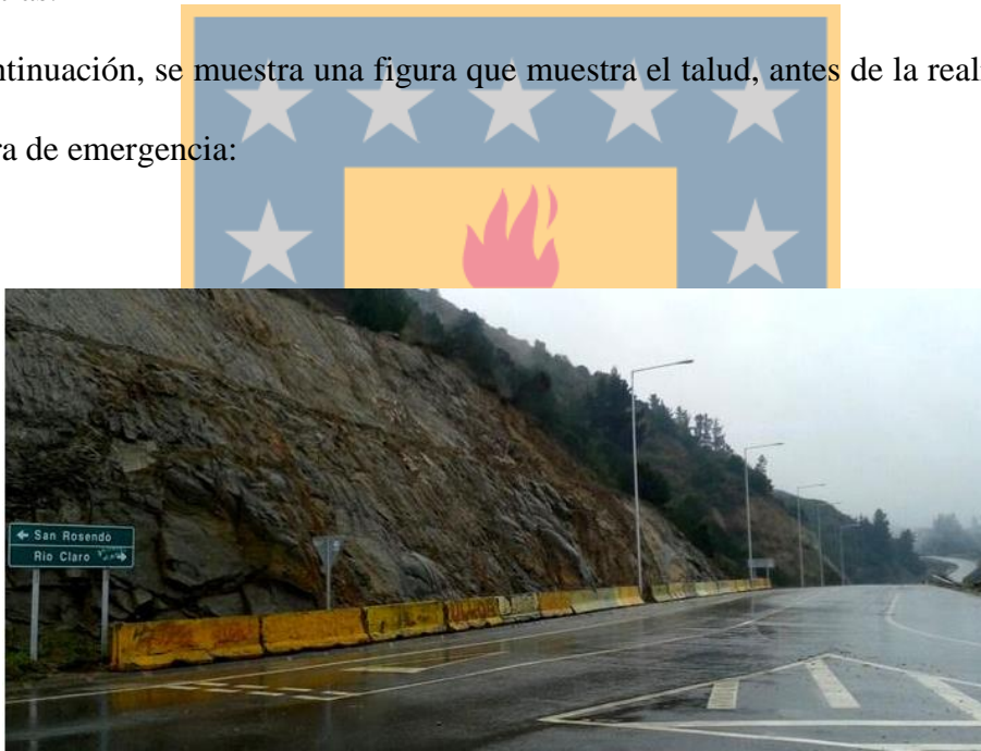
Figura 3: Talud antes de contrato de emergencia
