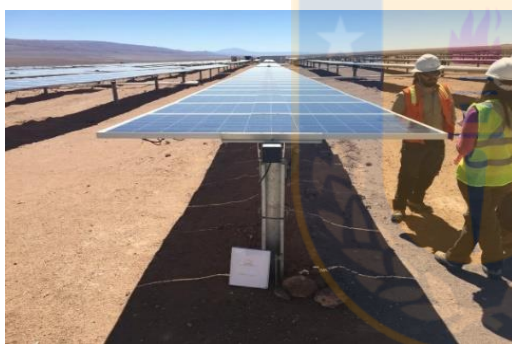
Figura 14. Estructura monoposte en sistema móvil-Planta Andes Solar.
