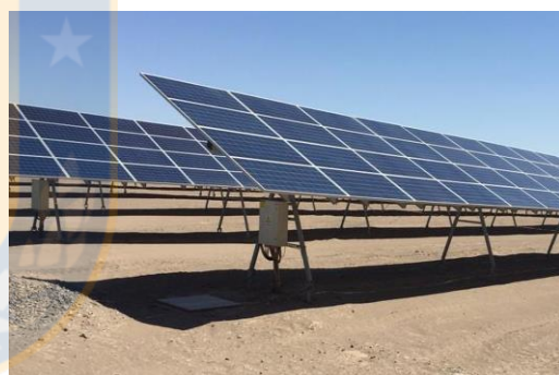
Figura 15. Estructura biposte en sistema móvil-Planta solar Finis Terrae.
