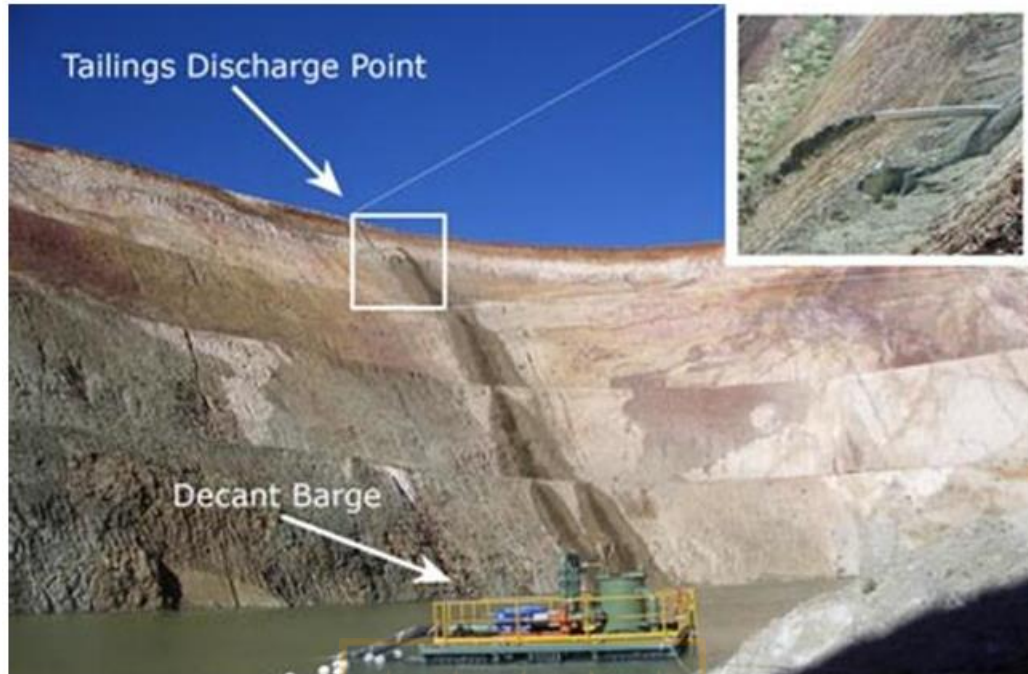
Figura 8.2 Relave dispuesto con el método de almacenamiento en pozo (Álvarez, 2017).
