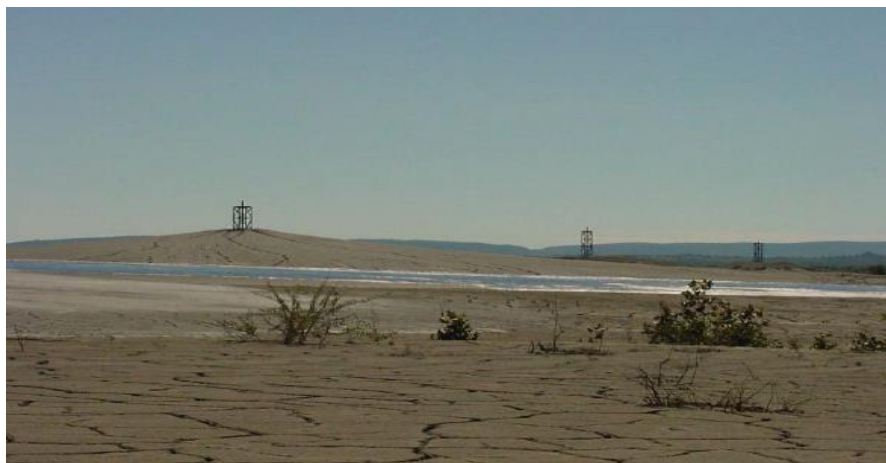
Figura 3.5 Depósito de relaves espesados a pasta (Ramírez, 2007).
