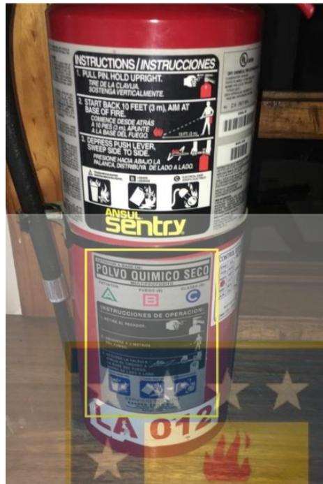
Figura 3. Etiqueta frontal con “instrucciones de uso” del extintor portátil de incendio.
