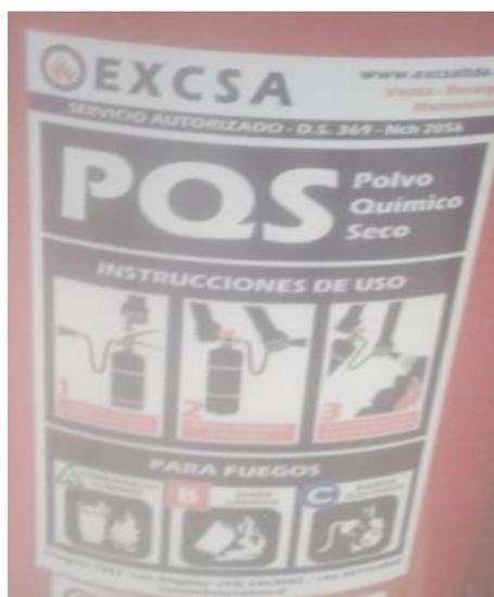
Figura 6. Etiqueta frontal con “instrucciones de uso” del extintor portátil de incendio.
