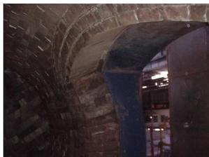
[Figura IV.12.2.](#) Detalle de la mampostería refractaria del convertidor en la zona de la boca<sup>3</sup>
