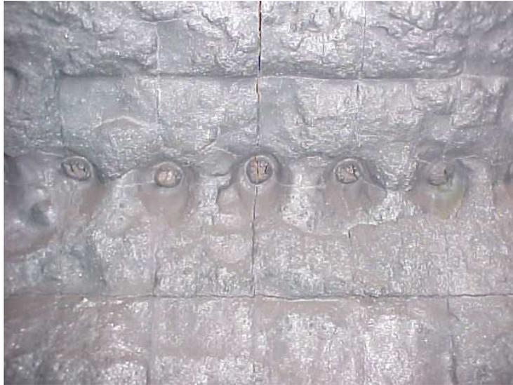
**Figura B.1.** Vista interior de la corrosión sufrida por el refractario en la zona de toberas
