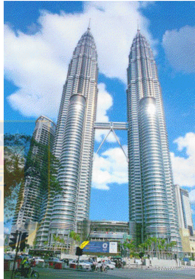
Fig. 3: las torres petronas, malasia. En éste caso la intención del diseñador sólo pudo ser implementado gracias a la incorporación significativa de sistemas de climatización artificial, sin los cuales la habitabilidad hubiera sido muy compleja de resolver.
