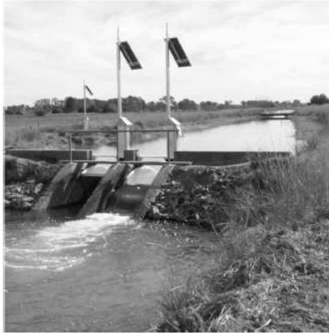
Fig. 2.2 Compuertas automatizadas, [1]
