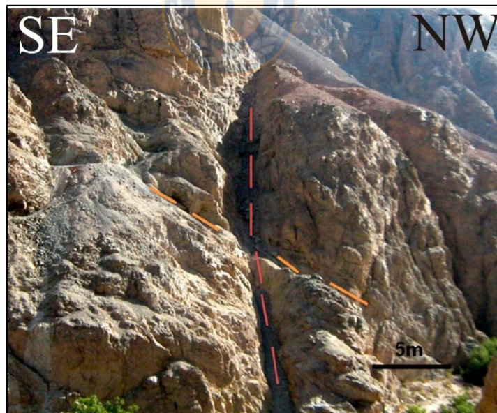
Fotografía 4.09. Falla acompañada de brecha y salbanda, que afecta a la ladera sur del sitio de presa.
