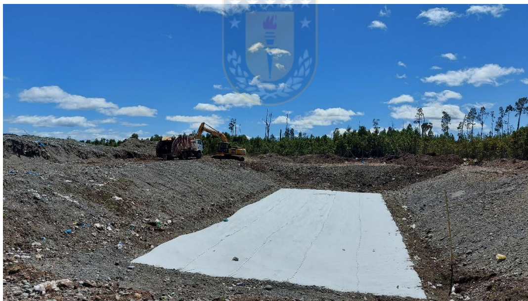
Imagen: Vertedero Municipal. Adecuación de vertedero Municipal.
