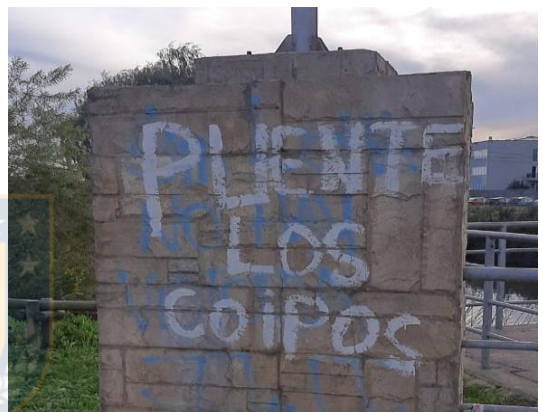
Puente "Los Coipos" Humedal Paicaví Figura N°60
