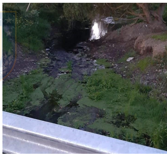
Puente sobre un canal Marisma Lengua Figura N°36
