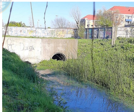
Canal aguas lluvias Humedal Price Figura N°12
