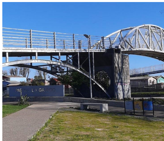
Puente y avenida vial Laguna Lo Galindo Figura N°26
