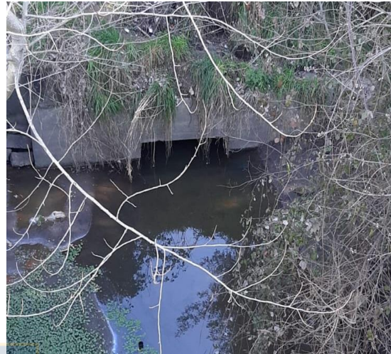
Canal de aguas lluvia Laguna Lo Galindo Figura N°10
