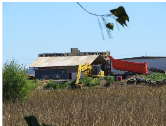
Retroexcavadoras Humedal Vasco da Gama Figura N°58
