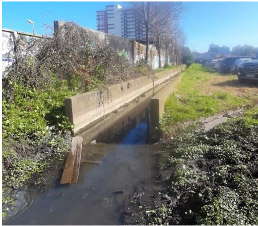
Canal aguas lluvias Laguna Tres Pascualas Figura N°13
