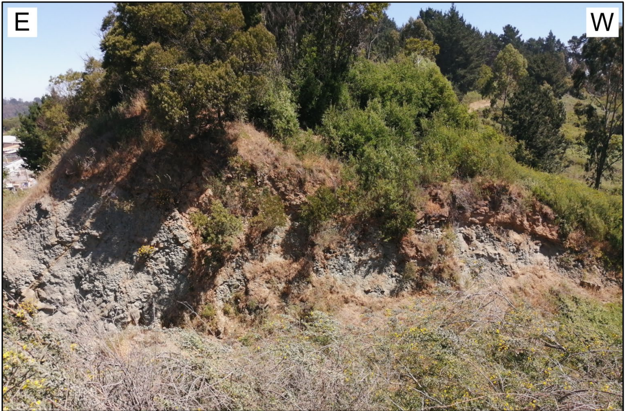
Figura 4.95: Imagen del talud meridional del corte ferroviario correspondiente a LAU – 5.
