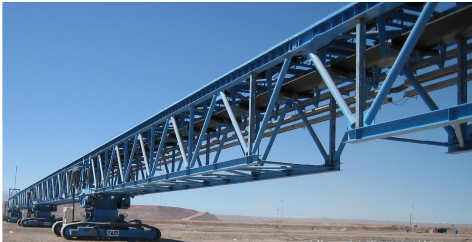
Figura 3.1 Imagen referencial Puente Apilador
