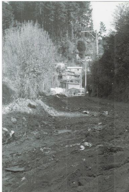
Figura 9: Calle Michimalongo antes del alcantarillado y la pavimentación
