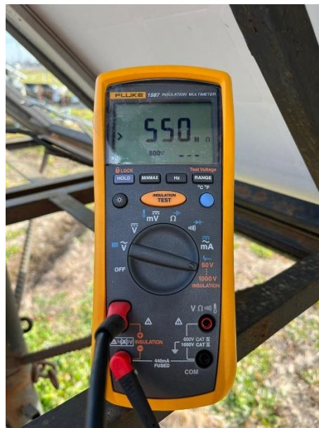
Figura 13. Prueba de aislamiento aplicando una tensión de 500 V.
