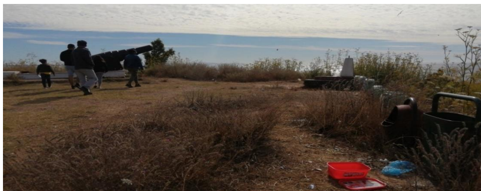
Figura 3: Estado actual del Monumento histórico Fuerte de Colcura. Fotografía del autor.
