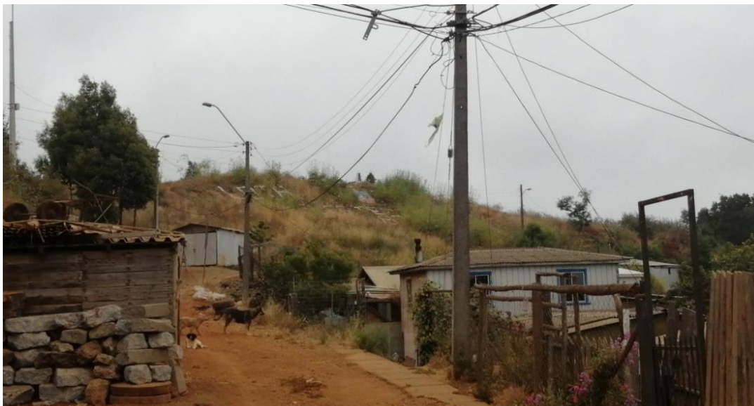
Figura 10: Construcciones irregulares y vista al fondo del Monumento histórico entre la maleza del descuido patrimonial. Fotografía del autor.
