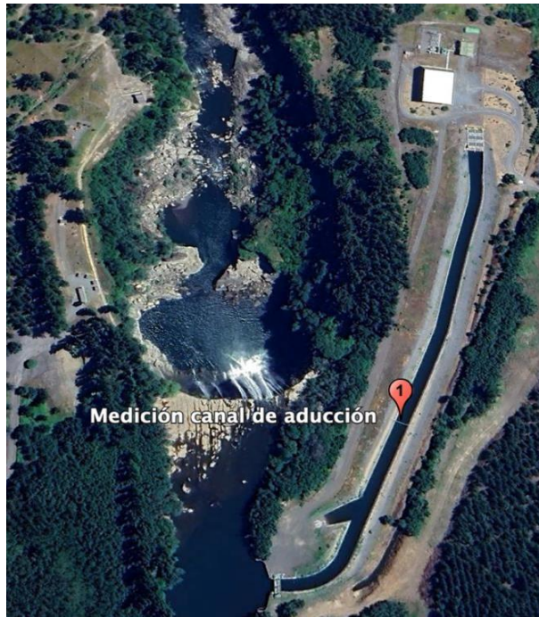
Figura 6.10. Punto de medición de caudal en el canal de aducción. Fuente: Elaboración propia en base a Informes de Seguimiento Medición de Caudales Central Itata. (2016-2025).
