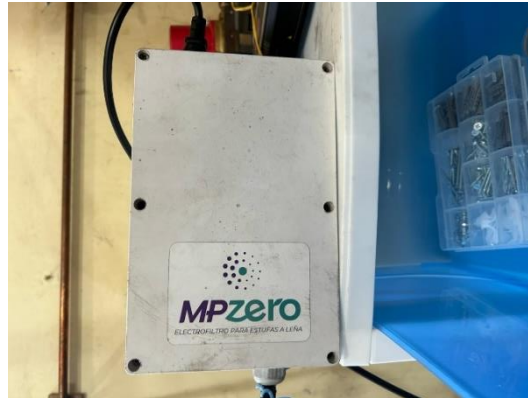
Figura 13: MPZERO instalado en el cañón.
