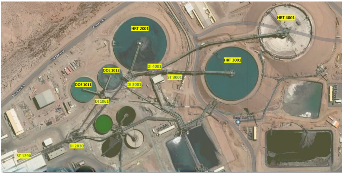
Figura 4. Vista aérea de los espesadores de relave en Área Cordillera de CMDIC.
