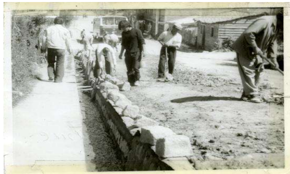
Imagen 9. Construcción de aguas lluvias
