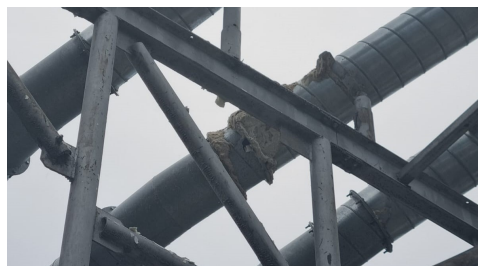
(a) Perforación en codo.
