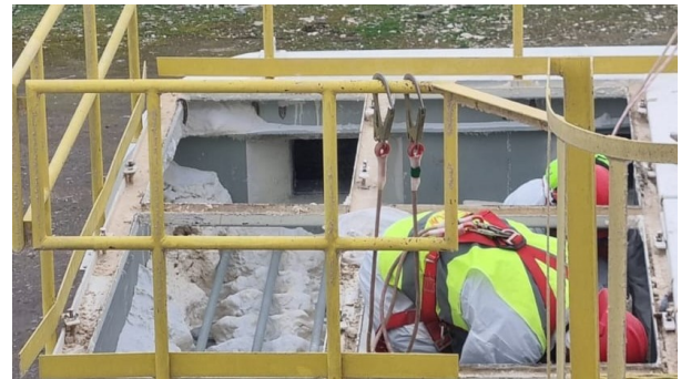
(b) Acumulación de polvo en la zona limpia del filtro.
