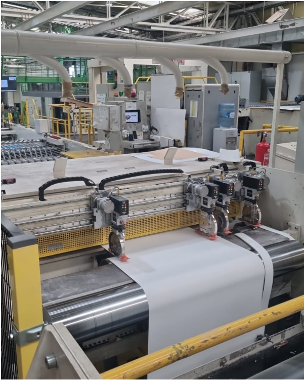
(a) Ausencia de ductos flexibles para la extracción de polvo en la PASABAN 4.
