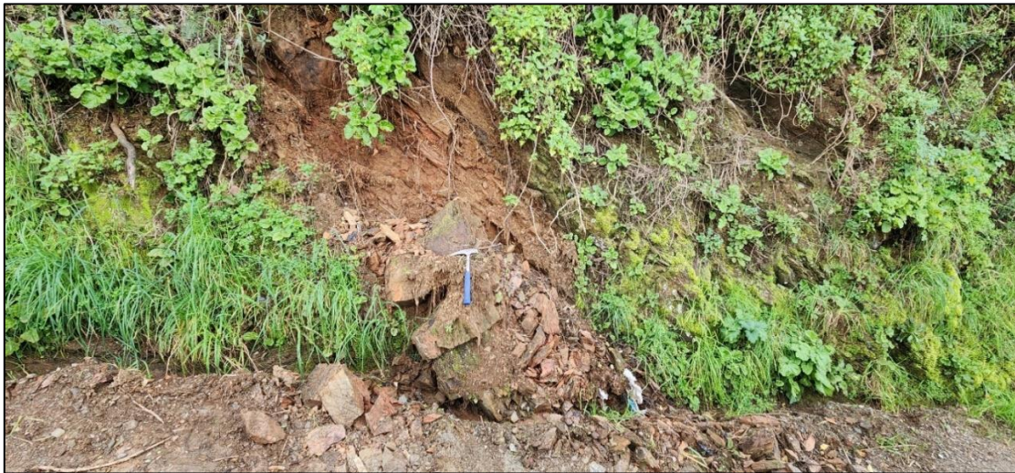
Figura 5.10: Caída de roca en el cerro La Unión.
