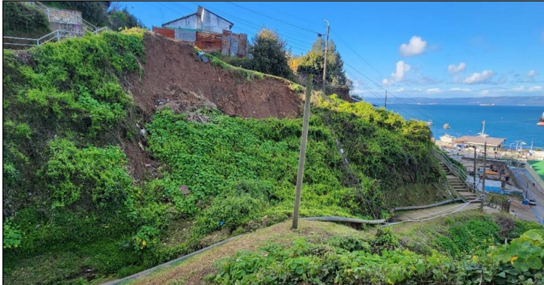
Figura 5.9: Deslizamiento de suelo en el cerro Cornou.
