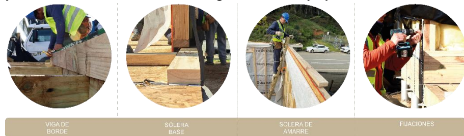
Figura 13. Ejemplos de armdo de elementos on site. Fuente Elaboración Propia.
