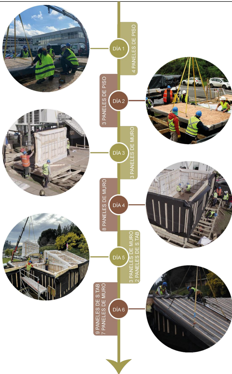
Figura 10. Línea temporal 6 días de montaje Vivienda Prototipo. Fuente Elaboración Propia.
