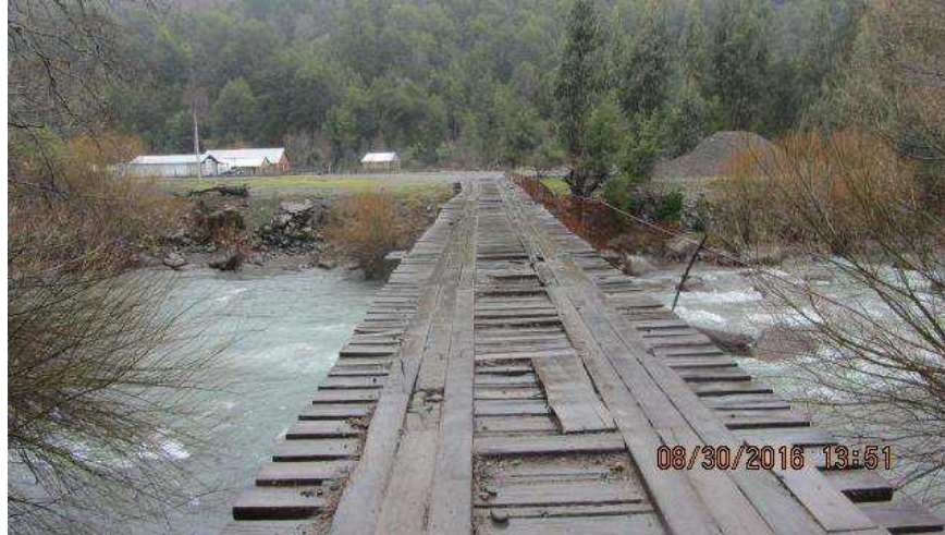
Fotografía N° 11. El antiguo puente Chichintahue que pasaba a través del Río Queuco. Fuente: Minuta Técnica 2023, Plan Buen Vivir.
