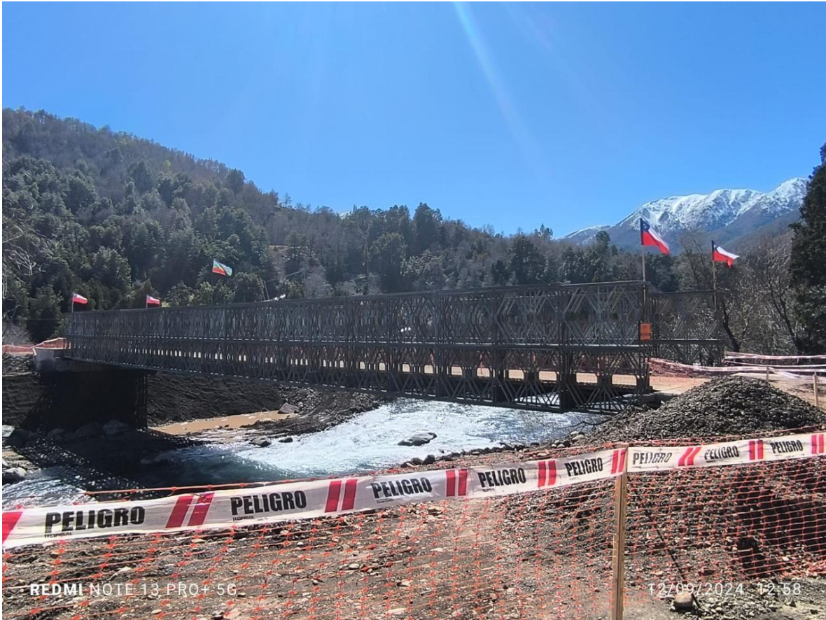
Fotografía N° 8. Construcción del Puente Chichintawe. Fecha 12 de septiembre de 2024. Fuente: Elaboración propia.
