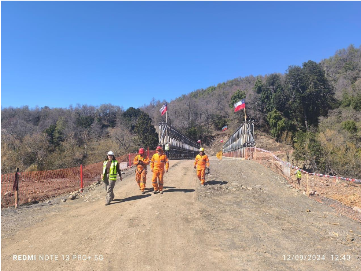
Fotografía N° 9. Fotografía tomada en terreno de los trabajadores de la obra “Reposición Puente Chichintahue”. Fecha: 12 de septiembre de 2024. Fuente: Elaboración propia.
