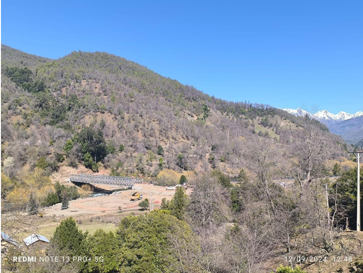
Fotografía N° 7. Vista panorámica de la construcción Puente Chichintawe. Fecha: 12 de septiembre de 2024.
