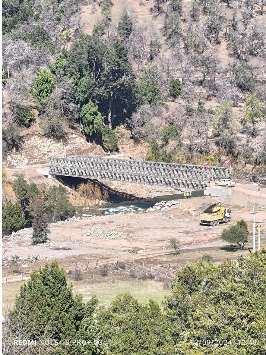
Fotografía N° 6. Vista panorámica de la construcción Puento Chichintawe. Fecha: 12 de septiembre de 2024. Fuente: Elaboración propia.
