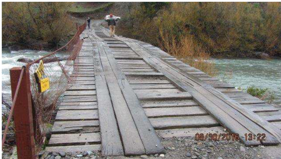
Fotografía N° 12. El antiguo puente Chichintahue que pasaba a través del Río Queuco. Fuente: Minuta Técnica 2023, Plan Buen Vivir.
