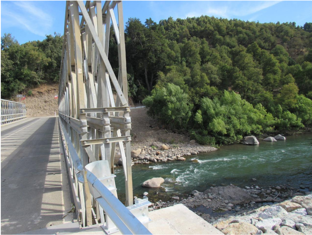
Fotografía N° 20. Nuevo puente Chichintahue junto al Río Queuco. Fuente: Elaboración propia.
