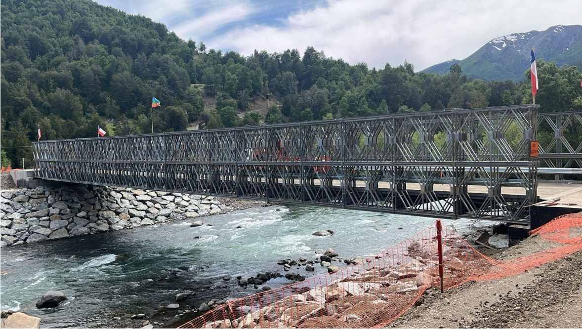
Fotografía N° 22. La obra reposición puente Chichintawe. Fecha: 6 de noviembre de 2024. Fuente: Equipo de Medio Ambiente y Territorio, Dirección de Vialidad, Región del Biobío.
