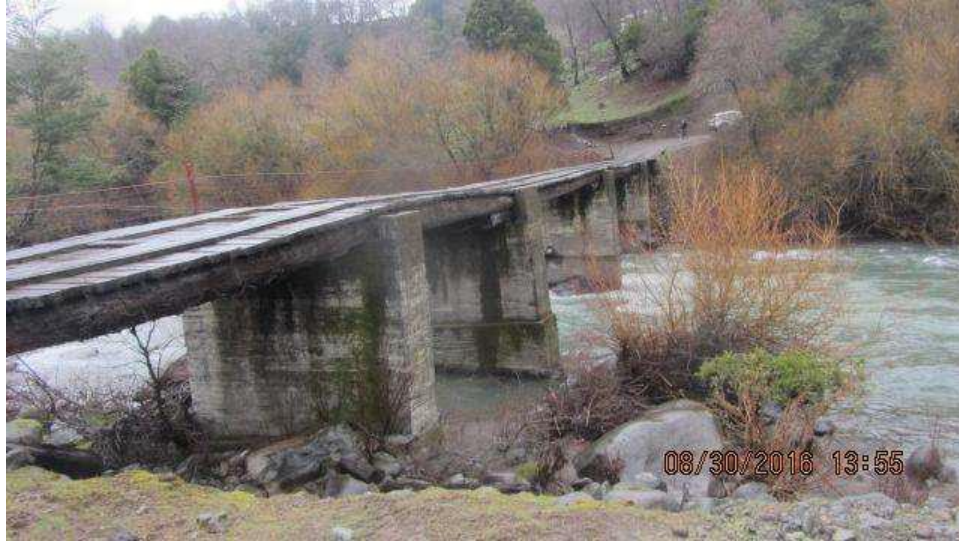
Fotografía N° 13. El antiguo puente Chichintahue que pasaba a través del Río Queuco. Fuente: Minuta Técnica 2023, Plan Buen Vivir.
